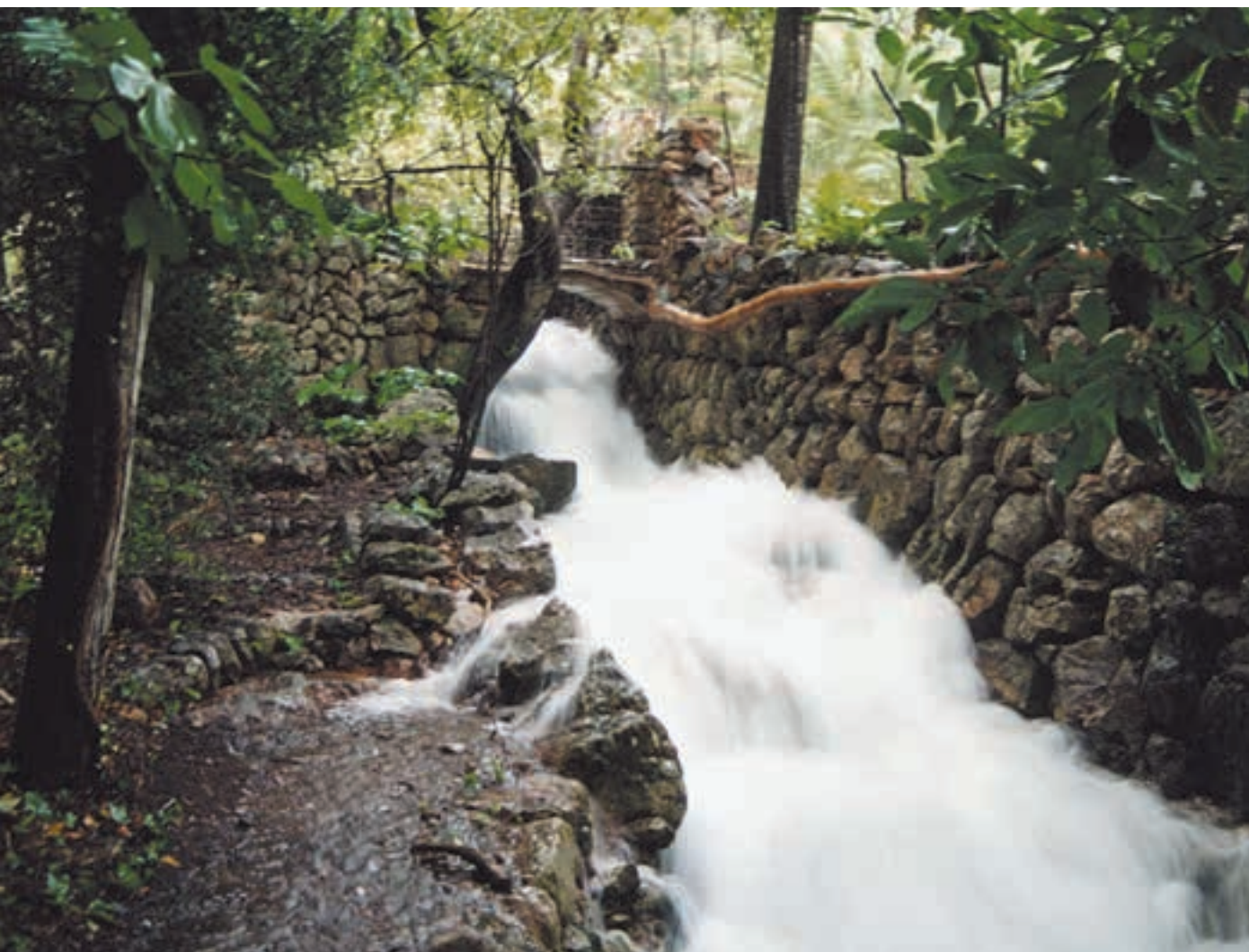
Torrentó de drenatge associat a un camp de marjades de Deià durant el temporal del 15 de novembre de 2001. L'efecte regulador de revingudes dels terrenys esgraonats va frenar els processos de revinguda en tot el sector de la serra de Tramuntana.
