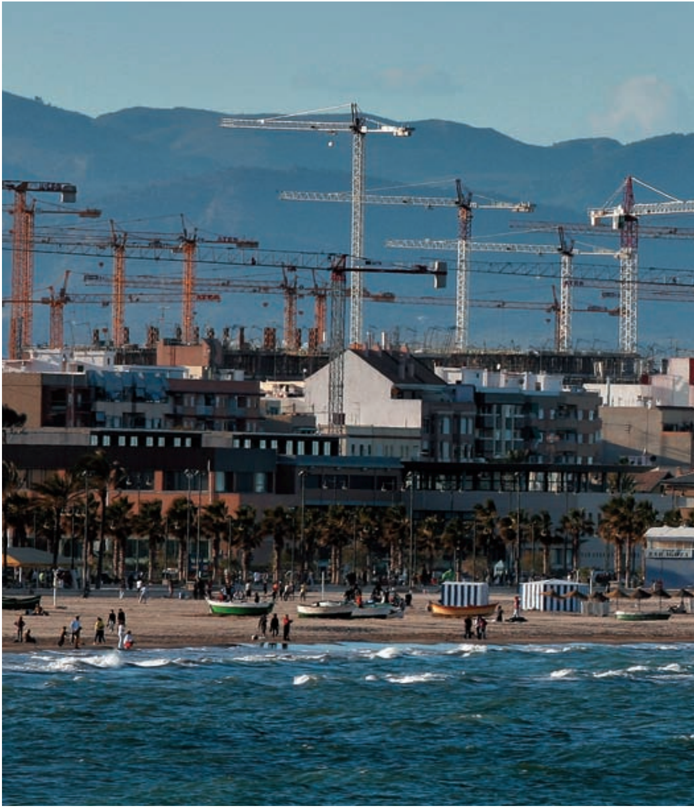
En la fotografía, playa de la Malvarrosa, con las grúas de construcción rompiendo el horizonte.
