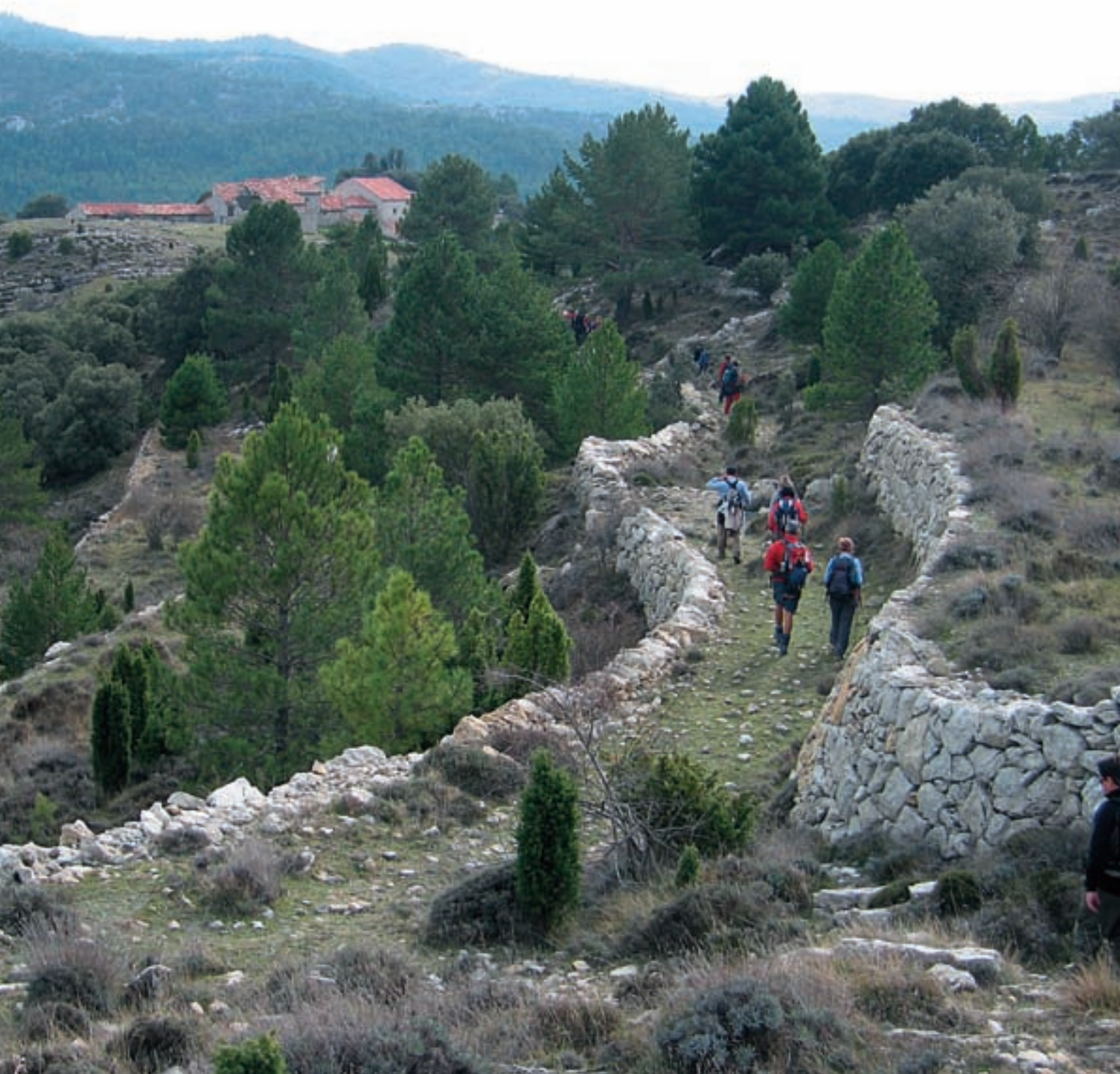
Els marges de pedra seca delimitaven els camins que unien els masos, pobles i llogarets de les comarques d'interior, com aquest camí de ferradura al Tossal d'en Canadé, al Mas Blanc (Els Ports).
