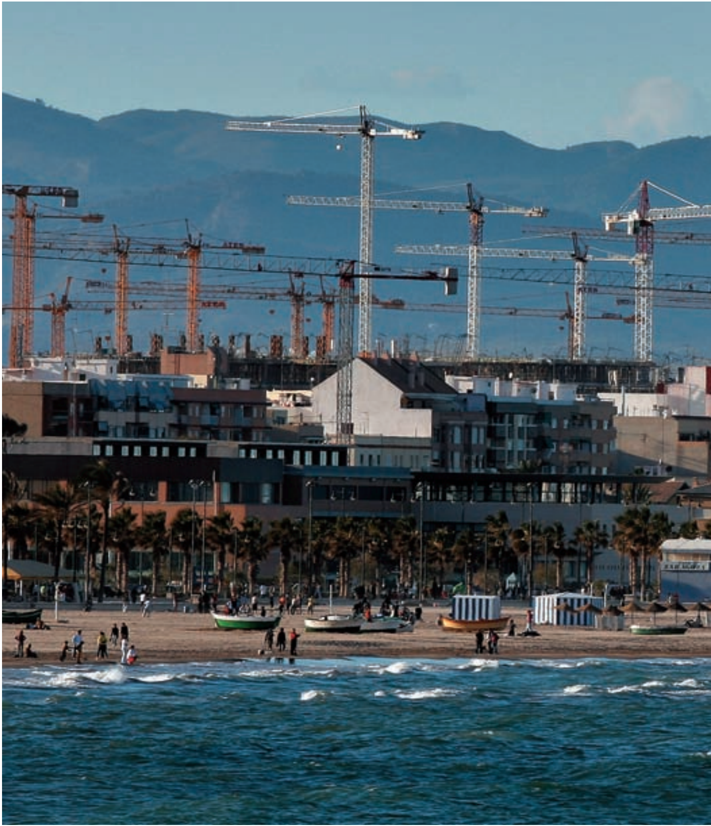
En la fotografia, platja de la Malvarossa, amb les grues de construcció trencant l'horitzó.
