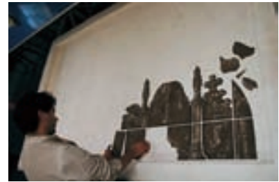
Procés de reintegració de calibres en un panell de la catedral d'Àvila durant la restauració que es va realitzar el 2005. En color es veuen les parts originals. Gran part de la restauració d'aquest vitrall de 1498 es va realitzar a partir de documentació sobre l'autor, Juan de Valdivieso. El tractament de pàtines s'ha fet amb grisalla. Els elements emprats per a la restauració són molt diferents als de l'original.
