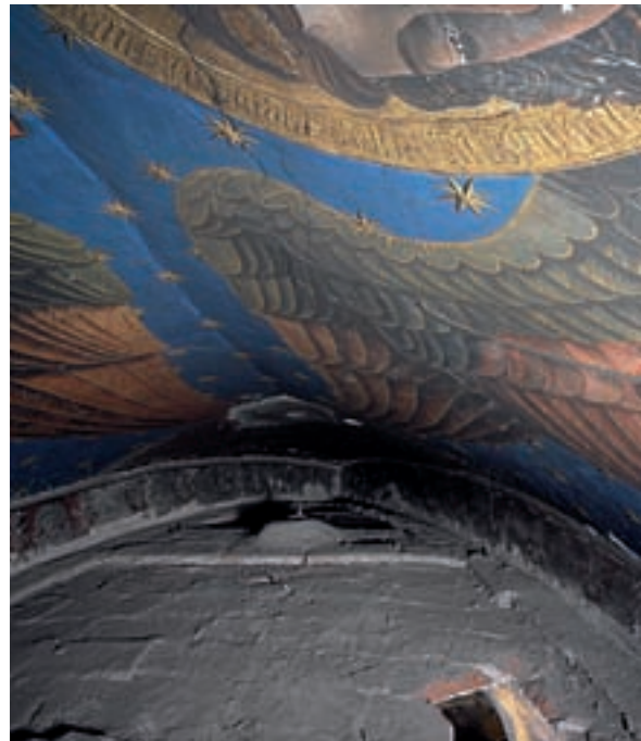
Doble rosca de rajola on es van practicar les cales per a valorar l'estat de les pintures.
