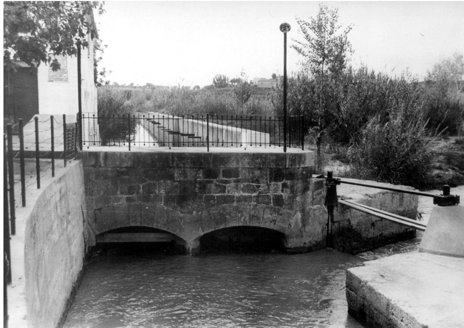
Casa de les comportes i almenara reial de la Séquia de Montcada (abans de la riuada de 1957)
