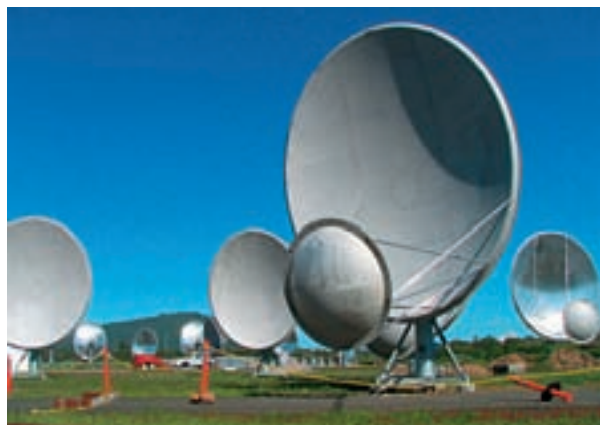
El telescopi Allen Array (ATA), actualment en construcció a Califòrnia amb 45 antenes ja en funcionament, disposarà d'un total de 350 antenes de sis metres de diàmetre.
