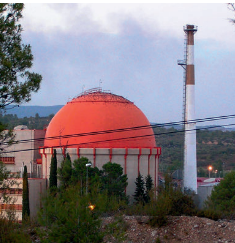
Imagen de la central nuclear José Cabrera en Almonacid de Zorita, Guadalajara. Fue la primera instalación de este tipo en España y estuvo en funcionamiento hasta 2006, que cesó su actividad.
